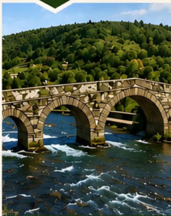
Puente de Vega de Espinareda
